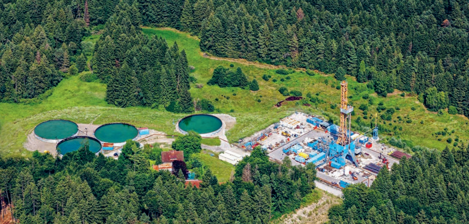
Geretsried in Bayern: Lange wurde hier vergebens nach ausreichend Thermalwasser gebohrt – mithilfe des «Eavor-Loop» könnte an dem Standort nun doch noch Wärme und sogar Strom erzeugt werden. * Foto: ZB / Euroluftbild / picture alliance
