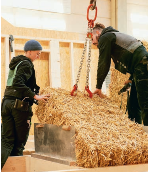
Zwei seitlich eingesteckte Metallbleche helfen beim Einpassen des auf Maß gepressten Ballens (links). Mit einem schweren Stämper werden die letzten Zentimeter in die Holzkonstruktion der späteren Wand gepresst (rechts).
