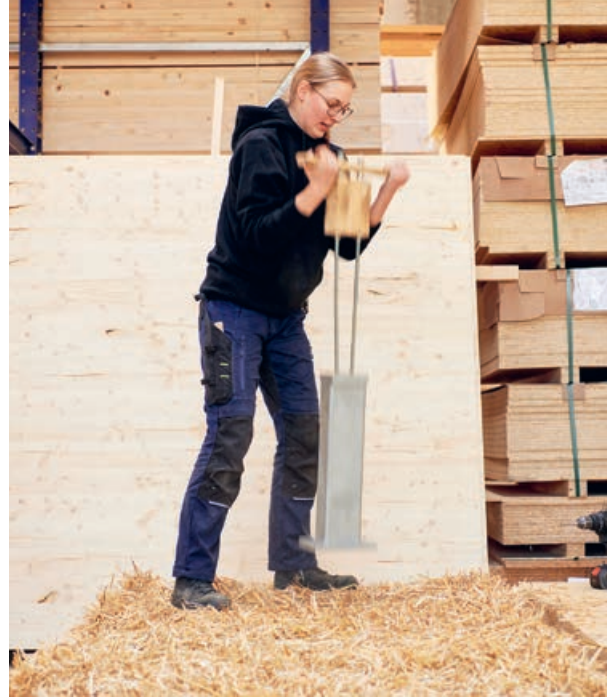
Zwei seitlich eingesteckte Metallbleche helfen beim Einpassen des auf Maß gepressten Ballens (links). Mit einem schweren Stämper werden die letzten Zentimeter in die Holzkonstruktion der späteren Wand gepresst (rechts).
